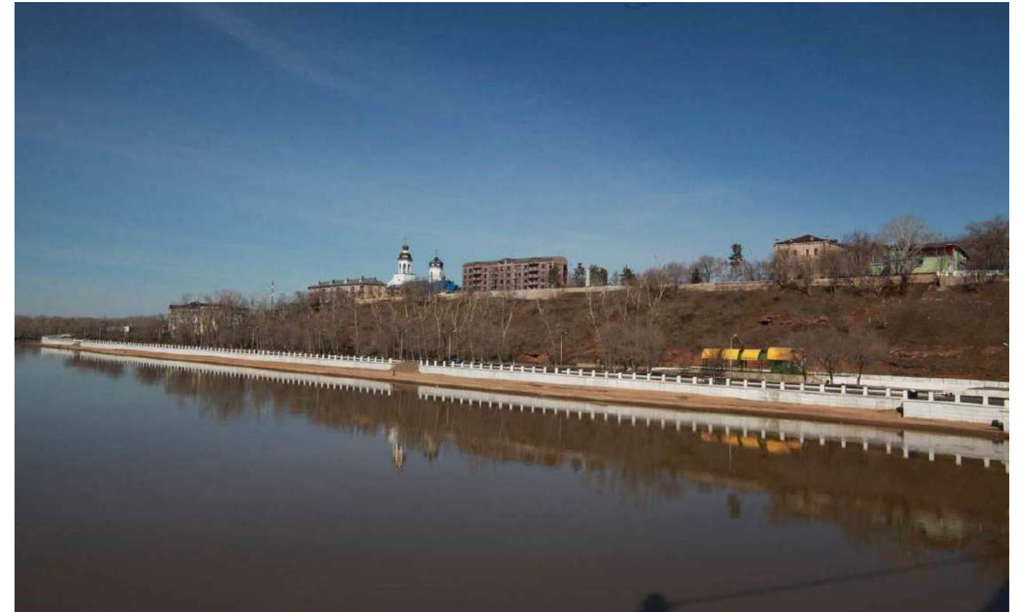
Фото 4 – Общий вид западной части правого берега набережной
