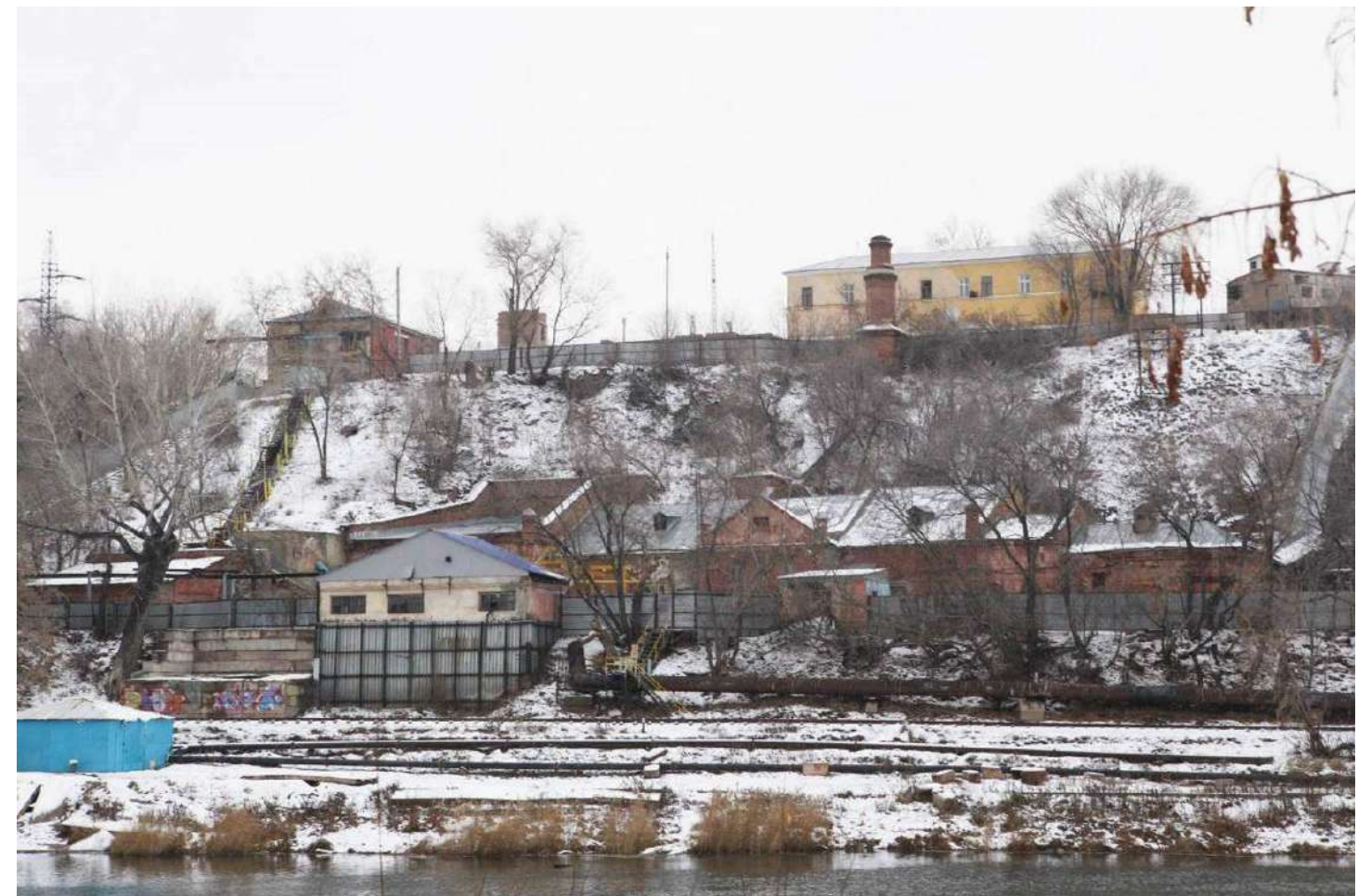
Фото 3 – Фрагмент набережной с видом на территорию «Водоканала»
