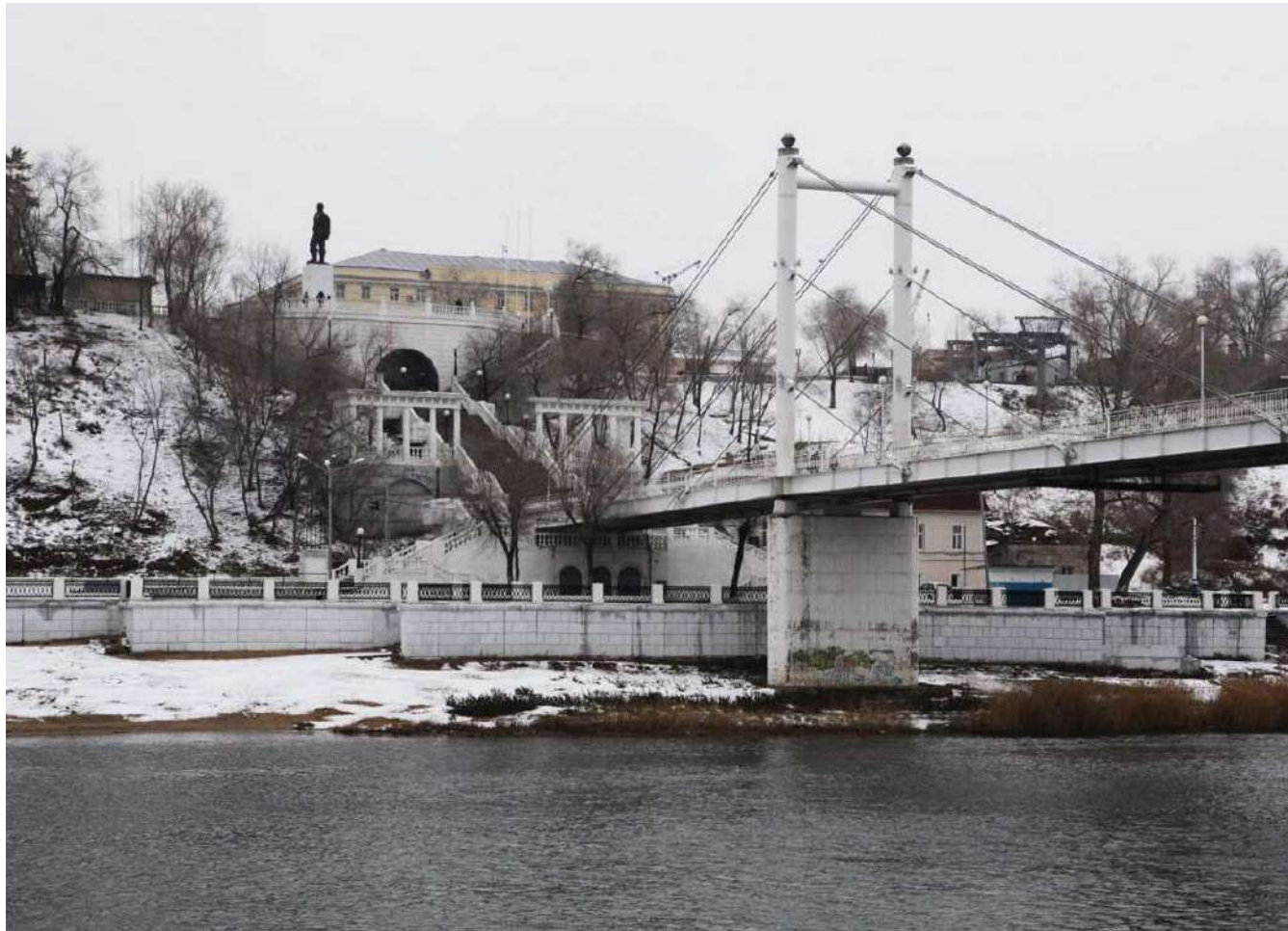
Фото 1 – Вид на набережную в северном направлении с левого берега
